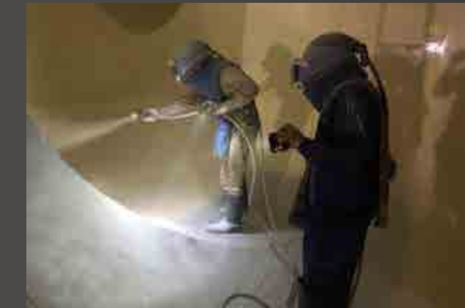
Làm sạch và sơn đường ống tuần hoàn (Sơn Polibrid) Nhà máy Nhiệt điện Mông Dương 2
