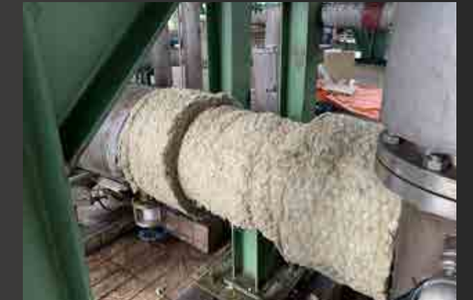
Lắp đặt bảo ôn phục vụ bảo trì (TA) Nhà máy sản xuất Amon Nitrat - Thái Bình
