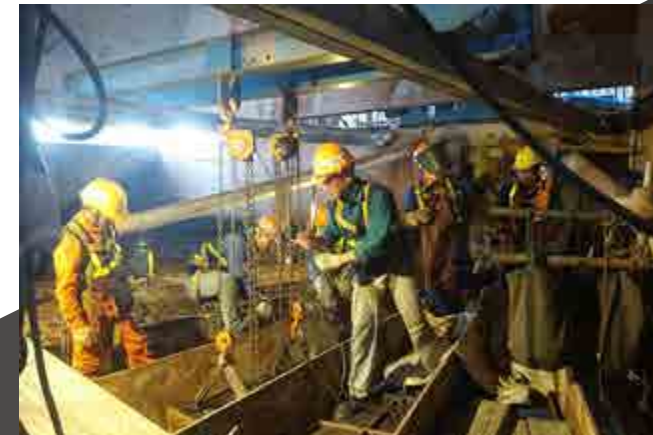
Thay thế bộ trao đổi nhiệt Absorber Nhà máy Nhiệt điện Mông Dương 2
