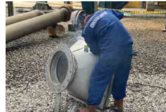
Gia công và lắp đặt phễu và đường ống vận chuyển bụi Nhà máy Nhiệt điện Mông Dương 2
