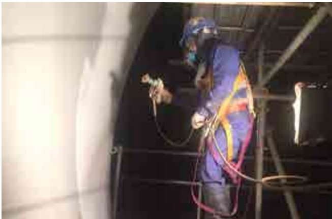
Làm sạch và sơn Ceilcote FGD, SCR, Absorber (Flake Lining) Nhà máy gang thép Formosa Hà Tĩnh
