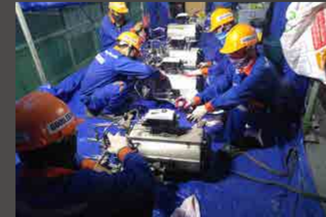
Bảo dưỡng Control valve & Actuator Nhà máy Nhiệt điện Mông Dương 2
