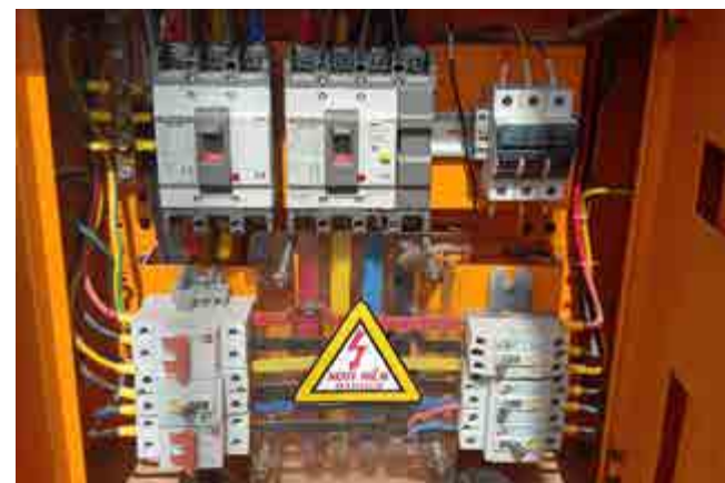
Lắp đặt tủ điện khu vực ESP & SDCC Nhà máy Nhiệt điện Mông Dương 2
