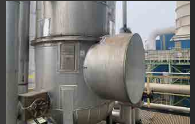
Lắp đặt bảo ôn phục vụ bảo trì (TA) Nhà máy sản xuất Amon Nitrat - Thái Bình
