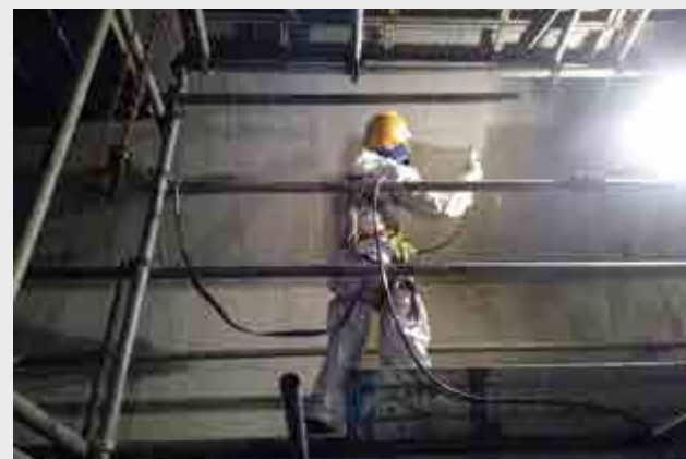
Làm sạch và sơn Ceilcote FGD (Flake Lining) Nhà máy lọc hóa dầu Nghi Sơn
