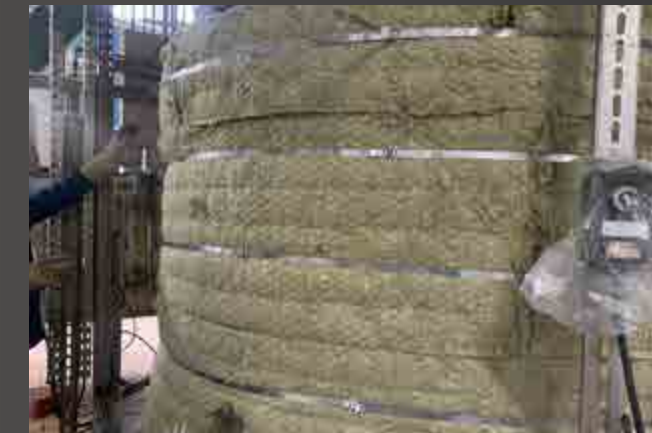
Lắp đặt bảo ôn phục vụ bảo trì (TA) Nhà máy sản xuất Amon Nitrat - Thái Bình
