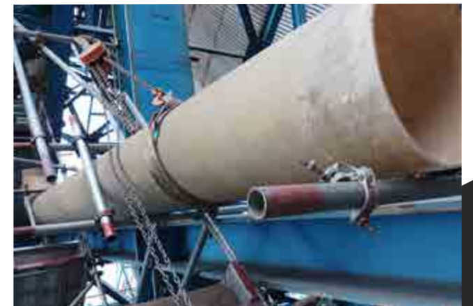
Gia công và lắp đặt phễu và đường ống vận chuyển bụi Nhà máy Nhiệt điện Mông Dương 2
