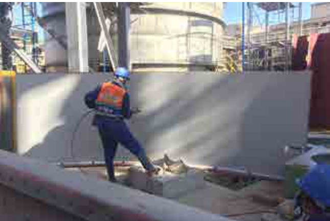
Làm sạch và sơn Ceilcote FGD, SCR, Absorber (Flake Lining) Nhà máy gang thép Formosa Hà Tĩnh
