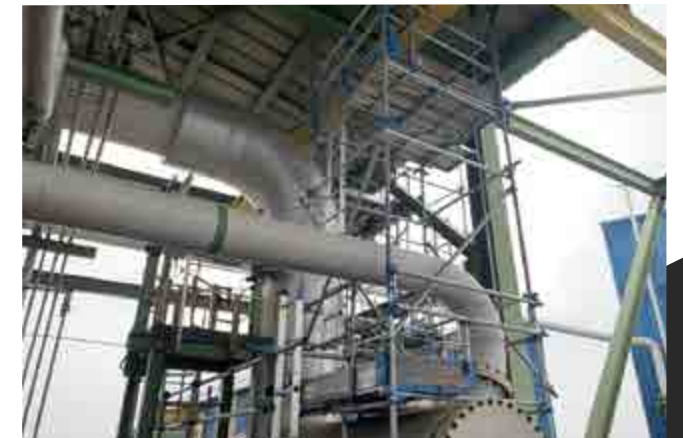
Lắp đặt giàn giáo phục vụ bảo trì (TA) Nhà máy sản xuất Amon Nitrat - Thái Bình
