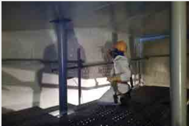
Làm sạch và sơn Ceilcote FGD (Flake Lining) Nhà máy lọc hóa dầu Nghi Sơn
