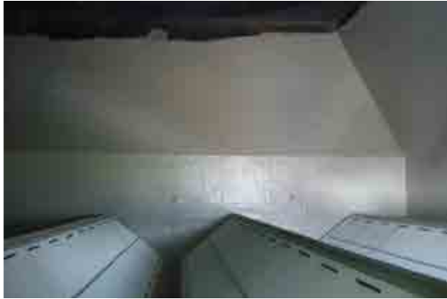
Làm sạch và sơn Ceilcote FGD (Flake Lining) Nhà máy lọc hóa dầu Nghi Sơn
