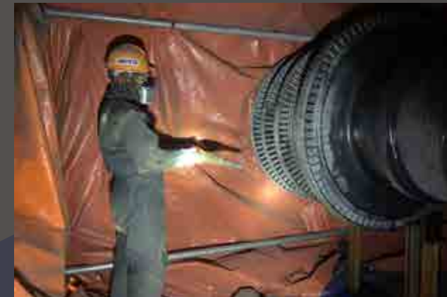
Làm sạch thiết bị Turbine Nhà máy nhiệt điện Vũng Áng 1
