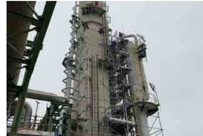
Lắp đặt giàn giáo phục vụ bảo trì (TA) Nhà máy sản xuất Amon Nitrat - Thái Bình
