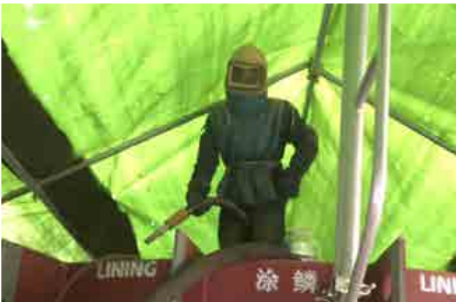
Làm sạch và sơn Ceilcote FGD, SCR, Absorber (Flake Lining) Nhà máy gang thép Formosa Hà Tĩnh
