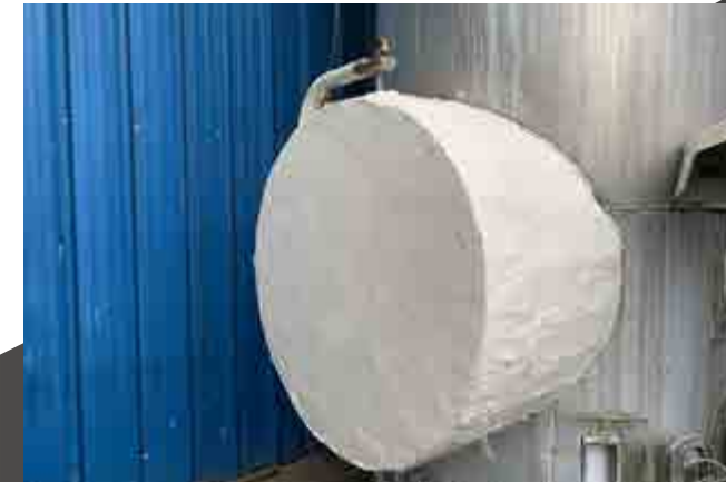
Lắp đặt bảo ôn phục vụ bảo trì (TA) Nhà máy sản xuất Amon Nitrat - Thái Bình
