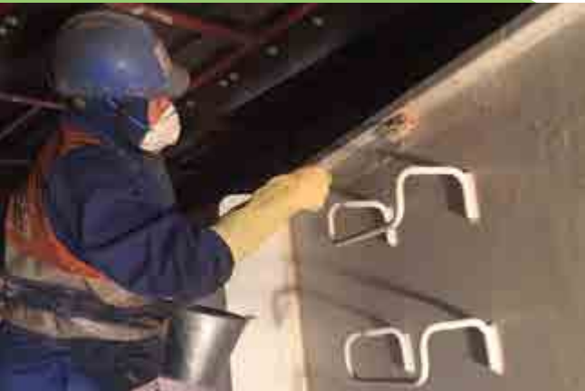
Làm sạch và sơn Ceilcote FGD, SCR, Absorber (Flake Lining) Nhà máy gang thép Formosa Hà Tĩnh
