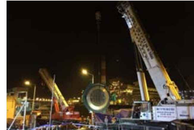
Lắp đặt Tie Valve - Nhà máy Nhiệt điện Mông Dương 2
