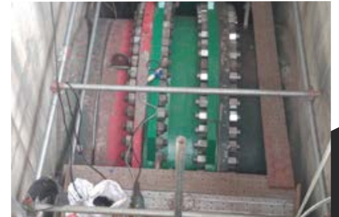
Lắp đặt Tie Valve - Nhà máy Nhiệt điện Mông Dương 2
