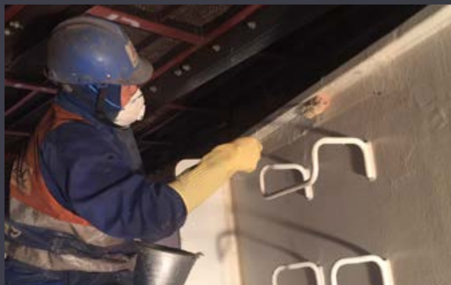
Làm sạch và sơn Ceilcote FGD, SCR, Absorber (Flake Lining) Dự án Formosa Hà Tĩnh
