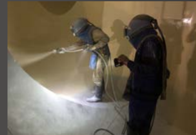
Làm sạch và sơn đường ống tuần hoàn (Sơn Polibrid) - Nhà máy Nhiệt điện Mông Dương 2
