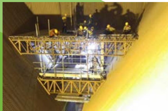
Lắp đặt giàn giáo bảo trì Boiler - Nhà máy Nhiệt điện Mông Dương 2
