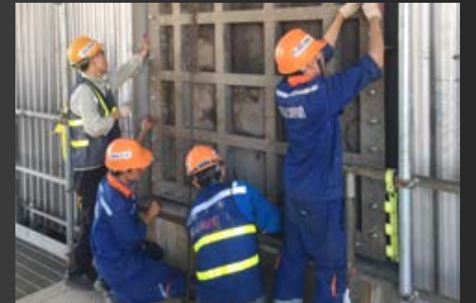
Thay thế bộ trao đổi nhiệt Absorber- Nhà máy Nhiệt điện Mông Dương 2
