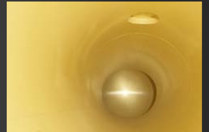
Làm sạch và sơn đường ống tuần hoàn (Sơn Polibrid) - Nhà máy Nhiệt điện Mông Dương 2
